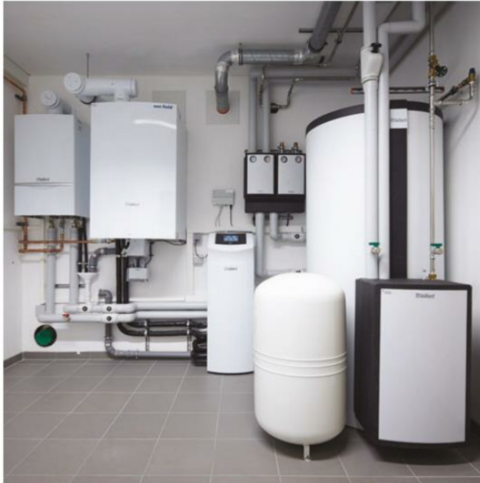
Abb. 6.6 Installation eines Vaillant Brennstoffzellen-Heizgerätes im Rahmen des Demonstrationsprojektes ene.field in einem Einfamilienhaus in Deutschland. (Bild: Vaillant)
