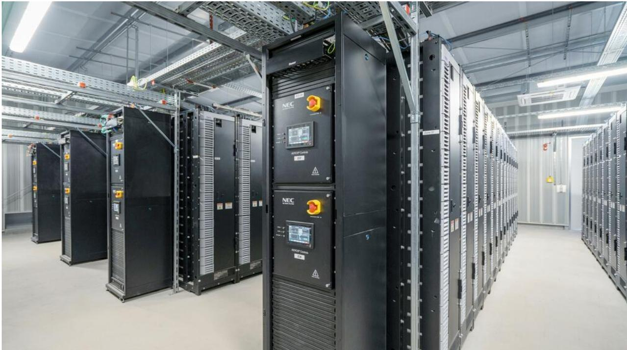
In Jardelund ist der größte Batteriespeicher Europas in Betrieb gegangen. In der Nähe der dänischen Grenze hat der niederländische Energieversorger Eneco einen Speicher mit einer Leistung von 46 Megawatt (MW) und einer Kapazität von mehr als 50.000 Kilowattstunden (kWh) ans Netz gebracht. Etwa 10.000 Lithium-Ionen-Batterien sind in dem XXL-Speicher installiert - genug, um etwa 5300 Haushalte für 24 Stunden mit Strom zu versorgen.
